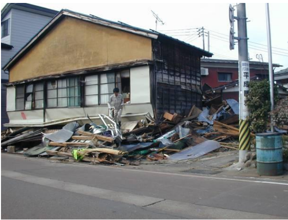
1階がつぶれて2階が1階のようになった住宅
