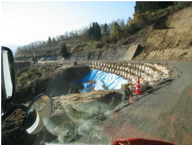
上の写真と同じ場所を11月20日に撮影したもの。 応急復旧工事により片側通行が可能になった。
