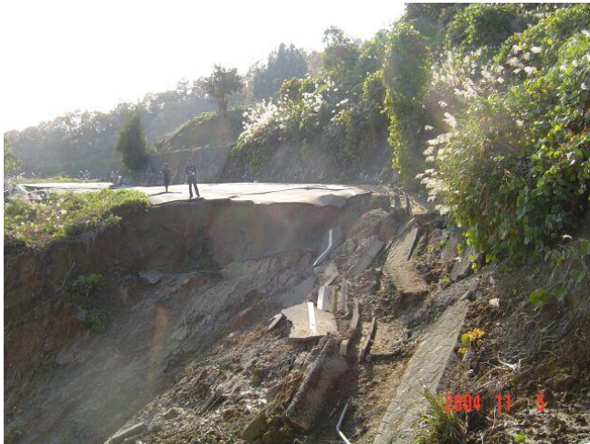
完全に崩壊してしまった道路 11月5日撮影
