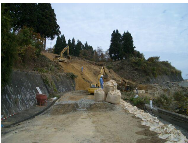
上の2枚と同じ道路を反対側から撮影。応急復旧工事の様子。
