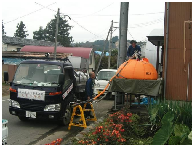
給水の様子左は名古屋市の給水車。右のオレンジ色のタンクに給水し、給水車の脇に写っている「うま」に取り付けられた蛇口から、住民がポリタンクなどで持って行く
