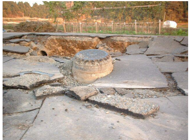
破損した道路と液状化により浮き上がったマンホール
