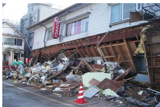
1階の店舗部分がつぶれてしまった商店
