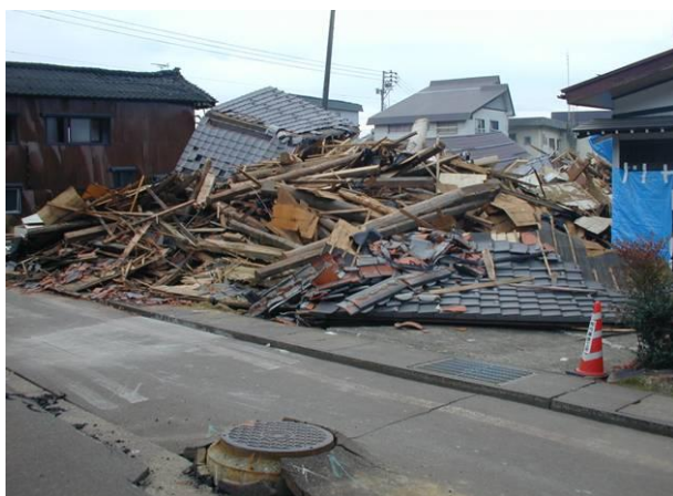
倒壊家屋と液状化により浮き上がったマンホール
